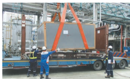
クレーンによる荷降ろし作業
