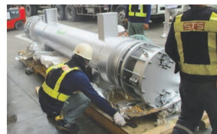
空炉関連設備の開梱搬入作業
