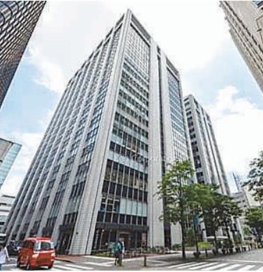
有楽町電気ビル
