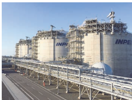
直江津LNGターミナル
