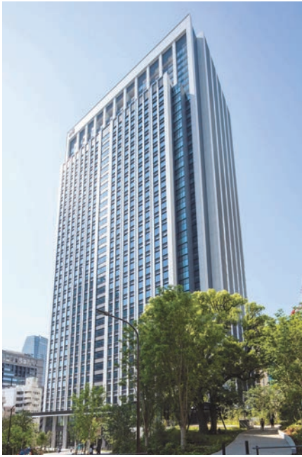
神谷町本社ビル
